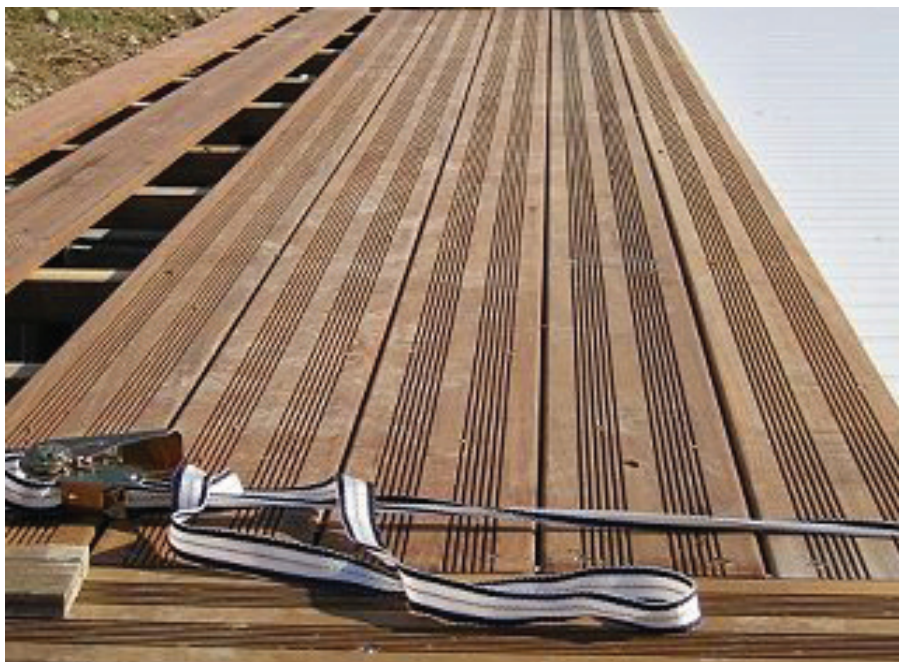
Gebruik van een spanband om de planken te rechten
